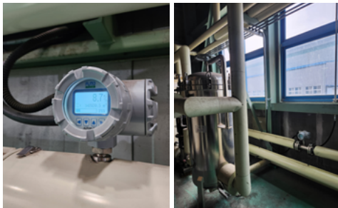
#1, #2RO 농축수 유량계 설치 및 일일 적산량(세아씨엠)
