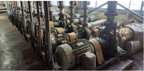
용수쿨링펌프 인버터 설치(세아씨엠)
